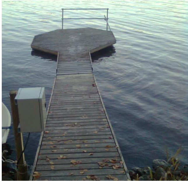
Vapaa-ajan asunnon laituri valmiina Sarapistonmäen edustalla. Kelluvan laiturin päässä on pohjaan tuettu teline, jota vastaan asennetaan alumiinitikkaisiin asennettu virrankehitin.
